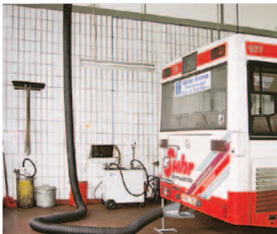
Oben: Saugschlitzkanal mit Schlauchwagen und leistungstarkem Ventilator. Links: Verwendung in einer Buswerkstatt
