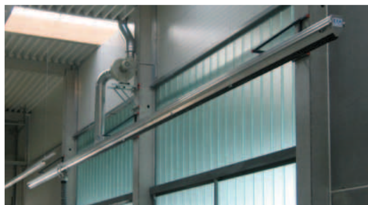
Oben: Saugschlitzkanal mit Schlauchwagen und leistungstarkem Ventilator. Links: Verwendung in einer Buswerkstatt
