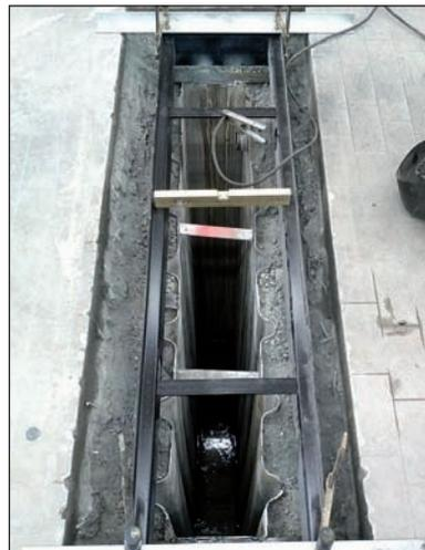
Ausrichtung für Betonierung des neuen Rahmens
