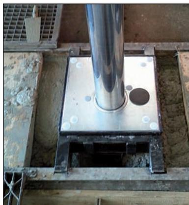
Einbetonieren des neuen Rahmens
